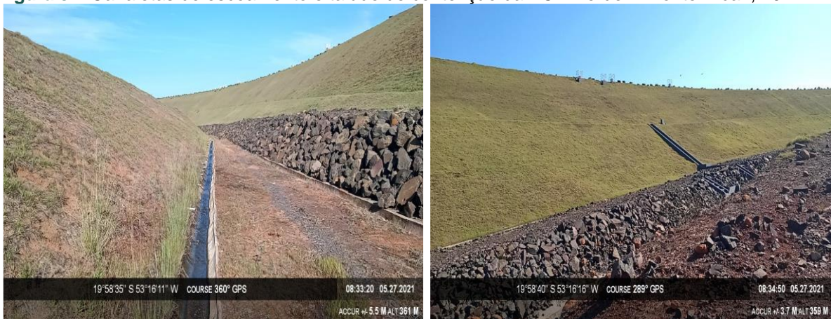
Figura 9 – Canaletas de escoamento e talude de contenção da PCH Verde 4. Fonte: Acari, 2021.
