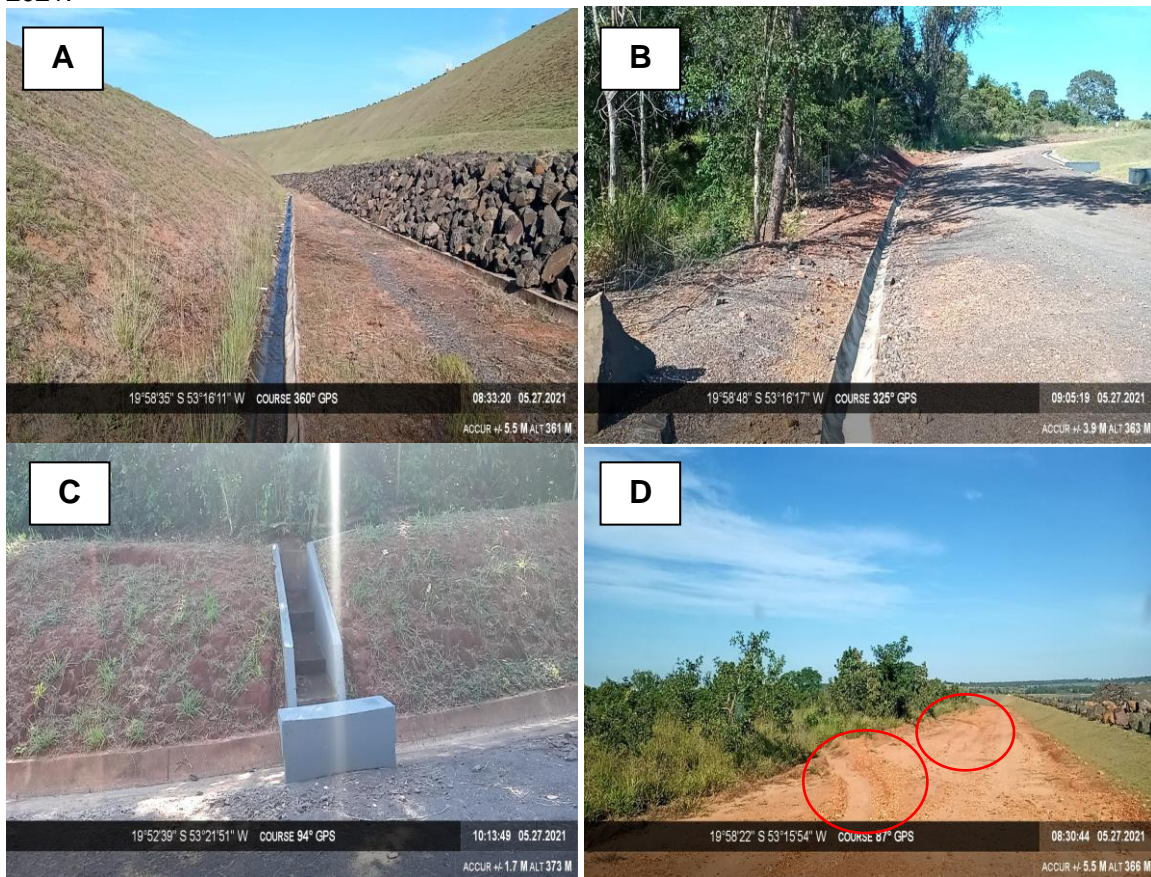
Figura 11 – Caneletas de escoamento da PCH Verde 4 (A, B e C); Curvas de nível nas estradas de acesso interno (D – destaque em vermelho). Município de Água Clara/MS. Campanha de maio de 2021.
