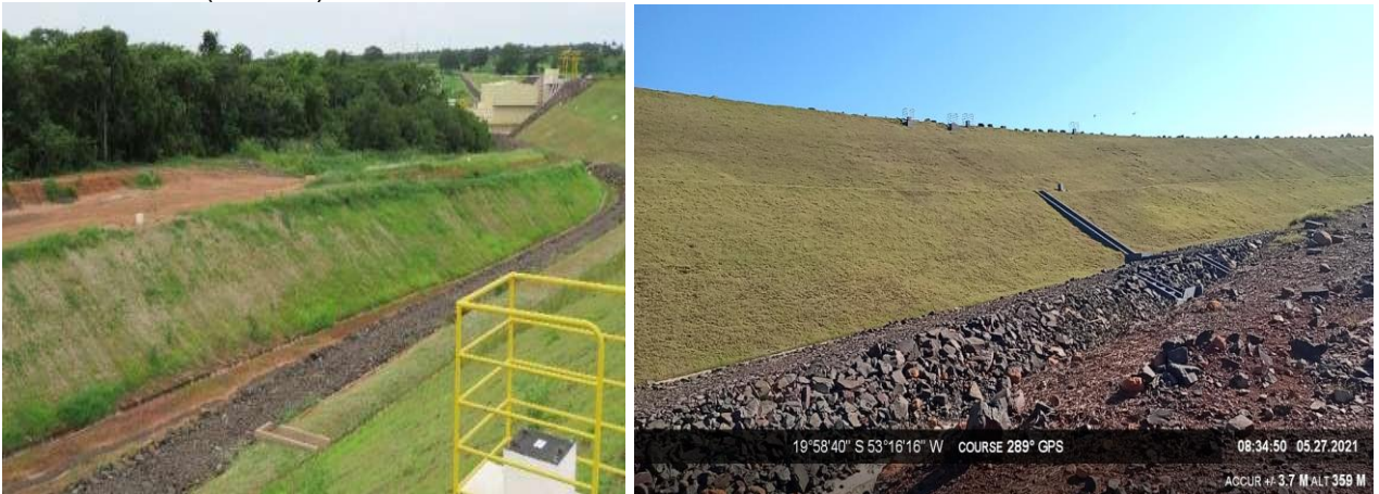
Figura 9 - Imagem aérea da Área Acesso provisório à jusante (ME). Junho de 2020 (à esquerda) e Maio de 2021 (à direita).
