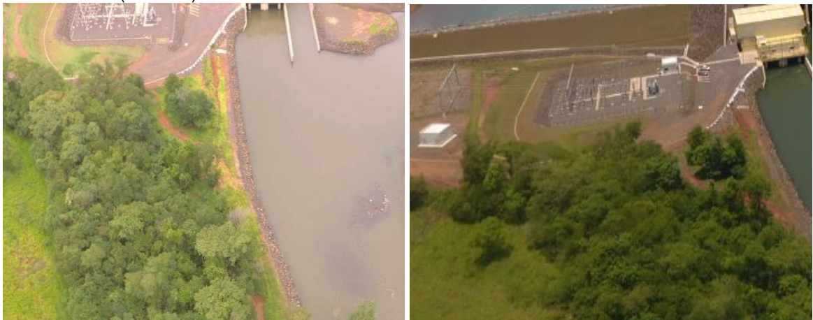
Figura 6 – Imagem aérea da área próxima à casa de força e subestação. Junho de 2020 (à esquerda) e Maio de 2021 (à direita).
