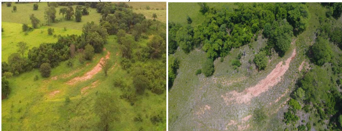
Figura 8 - Imagem aérea da área à jusante do barramento (área ampliada do canteiro). Junho de 2020 (à esquerda) e Maio de 2021 (à direita).
